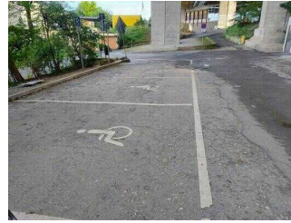
Parkplatz unter der Brücke
