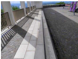
Rampe zum Eingang Bergstation
