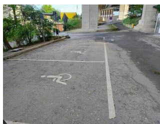
Parkplatz unter der Brücke
