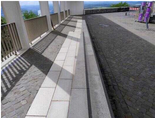
Rampe zum Eingang Bergstation
